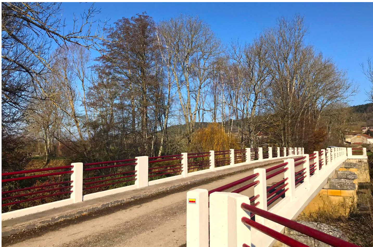
Piliers et barreaux ont été entièrement nettoyés et repeints
